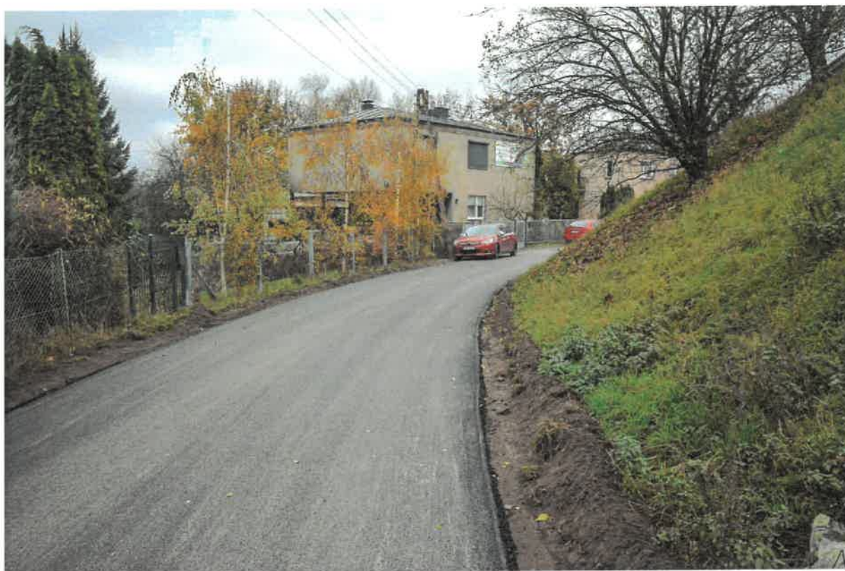
Zdjęcie Nr 3. Widok na nakładkę bitumiczną ułożoną po wykonanych robotach sanitarnych
