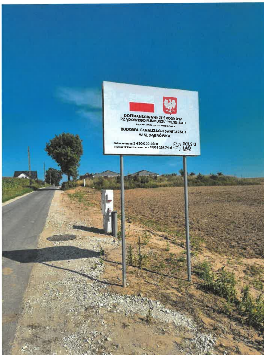
Zdjęcie Nr 6. Widok na przepompownię ścieków Nr P1
